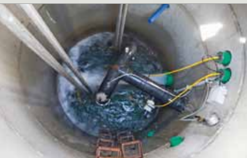
Blick in den Pumpenschacht
