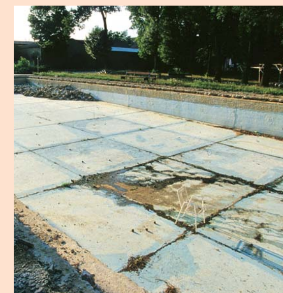
Das Betonbecken des alten Bründlbades in Neudorf
