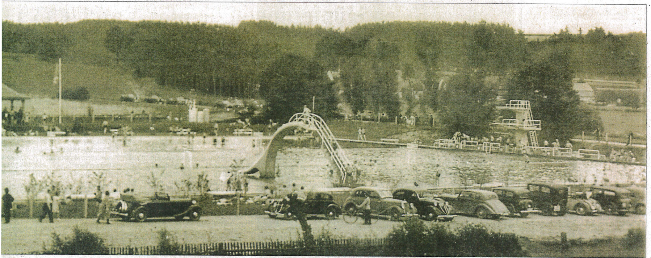
Am Anfang an ist das 1938 gebaute Windsbacher Waldstrandbad von den Bürgern aus weitem Umkreis gut angenommen worden, wie dieses Bild aus dem Jahr 1939 zeigt. Bis zur jetzigen Sanierung wurde an der Anlage fast nichts verändert. Repro: Stadt Windsbach
