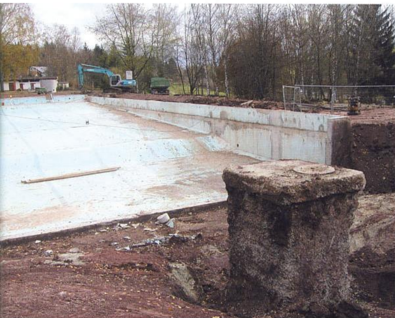
Der Umbau war eine Herausforderung an den ausführenden GaLaBau-Betrieb – insgesamt 5.000 Kubikmeter Erde wurde bewegt, 200 Tonnen Jurakalk eingebaut.
